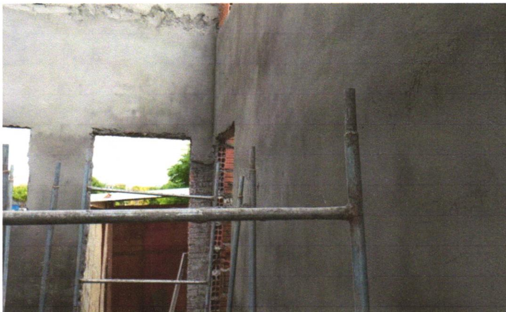
Foto 13 - MASSA ÚNICA, PARA RECEBIMENTO DE PINTURA, EM ARGAMASSA TRAÇO 1:2:8, PREPARO MANUAL, APLICADA MANUALMENTE EM FACES INTERNAS DE PAREDES, ESPESSURA DE 10MM, COM EXECUÇÃO DE TALISCAS. AF_06/2014
