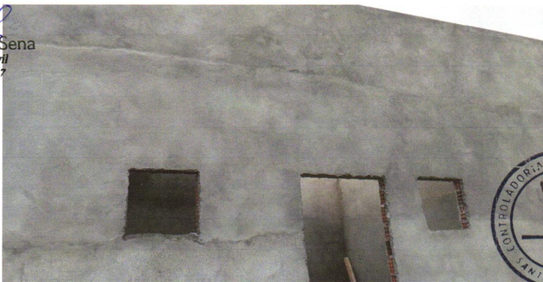
FOTO 02 – MASSA ÚNICA, PARA RECEBIMENTO DE PINTURA, EM ARGAMASSA TRAÇO 1:2:8, PREPARO MANUAL, APLICADA MANUALMENTE EM FACES INTERNAS DE PAREDES, ESPESSURA DE 10MM, COM EXECUÇÃO DE TALISCAS. AF_06/2014
