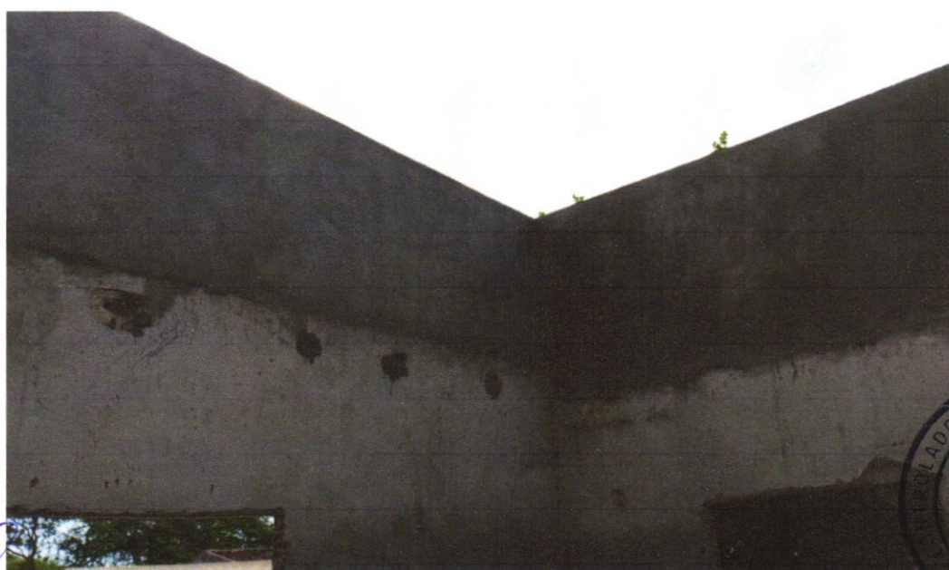
Foto 14 - MASSA ÚNICA, PARA RECEBIMENTO DE PINTURA, EM ARGAMASSA TRAÇO 1:2:8, PREPARO MANUAL, APLICADA MANUALMENTE EM FACES INTERNAS DE PAREDES, ESPESSURA DE 10MM, COM EXECUÇÃO DE TALISCAS. AF_06/2014
