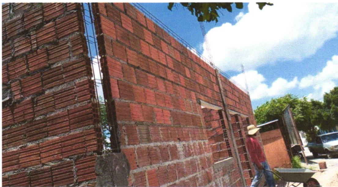
Foto 15 - (COMPOSIÇÃO REPRESENTATIVA) EXECUÇÃO DE ESTRUTURAS DE CONCRETO ARMADO, PARA EDIFICAÇÃO HABITACIONAL UNIFAMILIAR TÉRREA (CASA EM EMPREENDIMENTOS), FCK = 25 MPA. AF_01/2017
