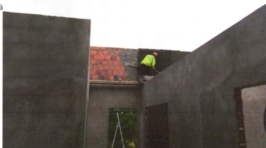
FOTO 06 – MASSA ÚNICA, PARA RECEBIMENTO DE PINTURA, EM ARGAMASSA TRAÇO 1:2:8, PREPARO MANUAL, APLICADA MANUALMENTE EM FACES INTERNAS DE PAREDES, ESPESSURA DE 10MM, COM EXECUÇÃO DE TALISCAS. AF 06/2014
