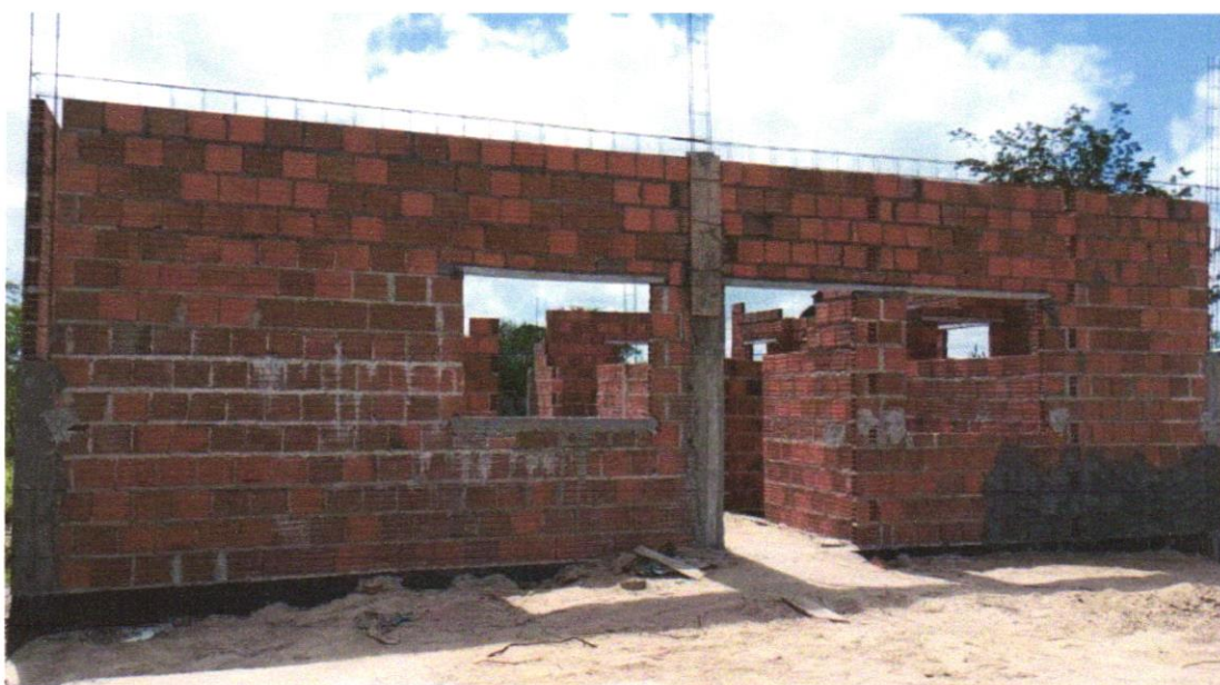
Foto 16 - (COMPOSIÇÃO REPRESENTATIVA) EXECUÇÃO DE ESTRUTURAS DE CONCRETO ARMADO, PARA EDIFICAÇÃO HABITACIONAL UNIFAMILIAR TÉRREA (CASA EM EMPREENDIMENTOS), FCK = 25 MPA. AF_01/2017
