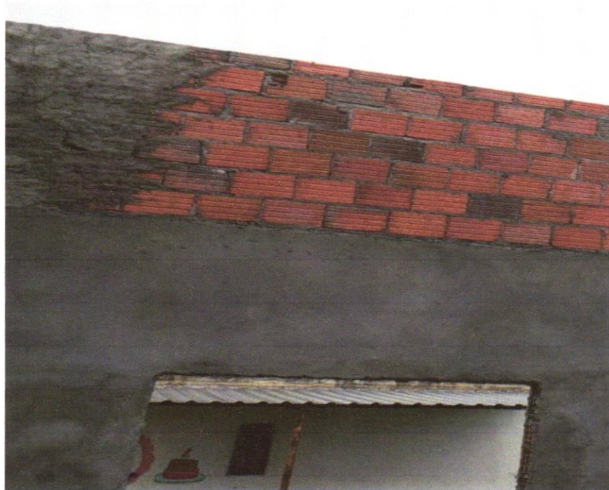
FOTO 05 – CHAPISCO APLICADO EM ALVENARIAS E ESTRUTURAS DE CONCRETO INTERNAS, COM COLHER DE PEDREIRO. ARGAMASSA TRAÇO 1:3 COM PREPARO EM BETONEIRA 400L. AF_06/2014
