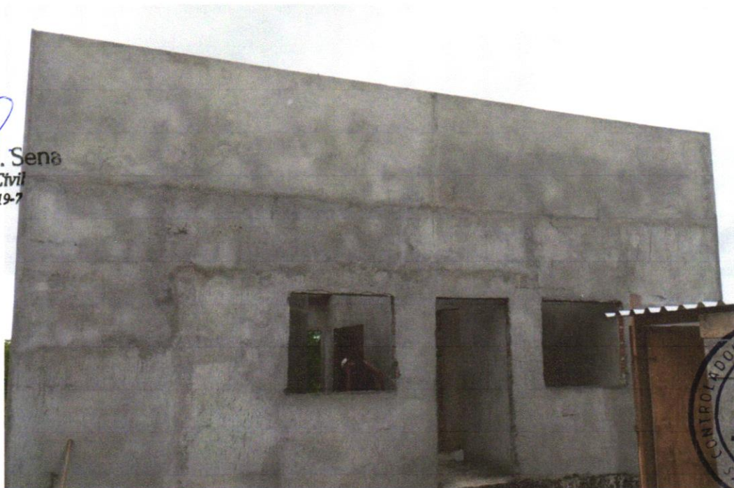
FOTO 04 - MASSA ÚNICA, PARA RECEBIMENTO DE PINTURA, EM ARGAMASSA TRAÇO 1:2:8, PREPARO MANUAL, APLICADA MANUALMENTE EM FACES INTERNAS DE PAREDES, ESPESSURA DE 10MM, COM EXECUÇÃO DE TALISCAS. AF_06/2014
